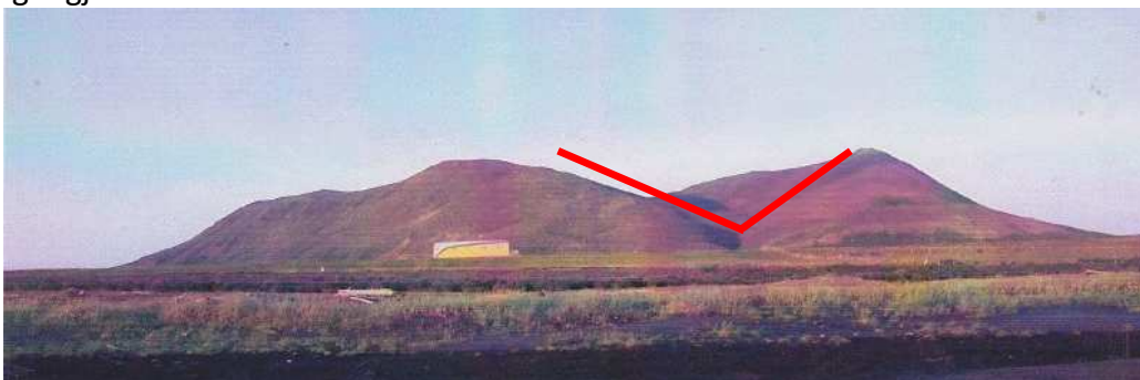
Rauða línan sýnir misgengið við Valþjófsstaðafjall, skammt frá Kópaskeri.
